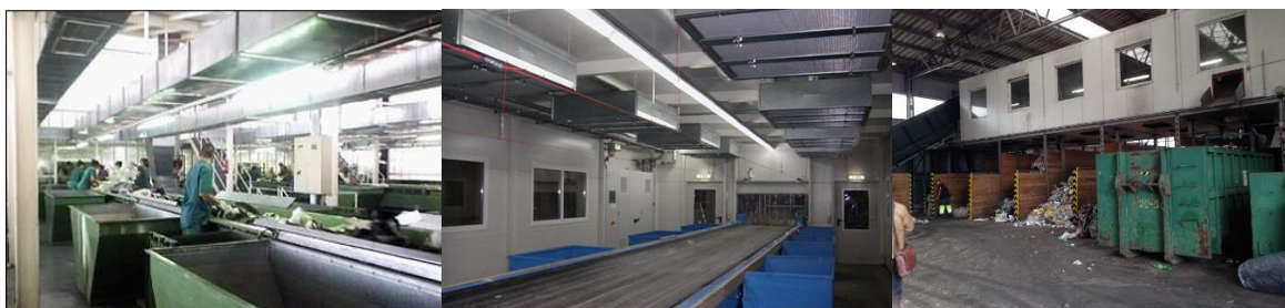
Slika 26. Pregled elemenata sortirnice
