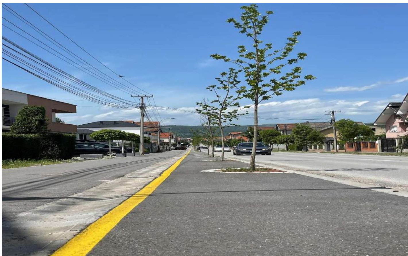
Foto 23. Gjendja e tanishme e shtegut të këmbësorëve ana e majtë, ana e djathtë do bëhet në të ardhmen
